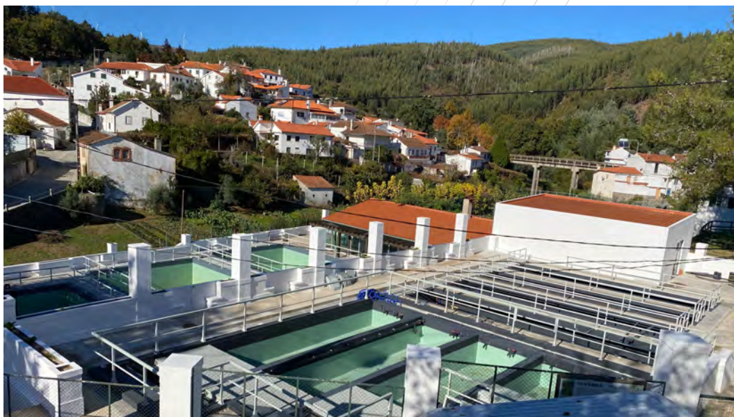
Reabilitação do Posto Aquícola de Campelo - Tanques exteriores
